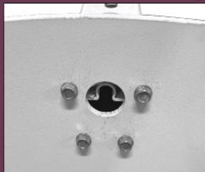
Fixation du pied par vis inox et trou d'évacuation pour l'eau et le sable
